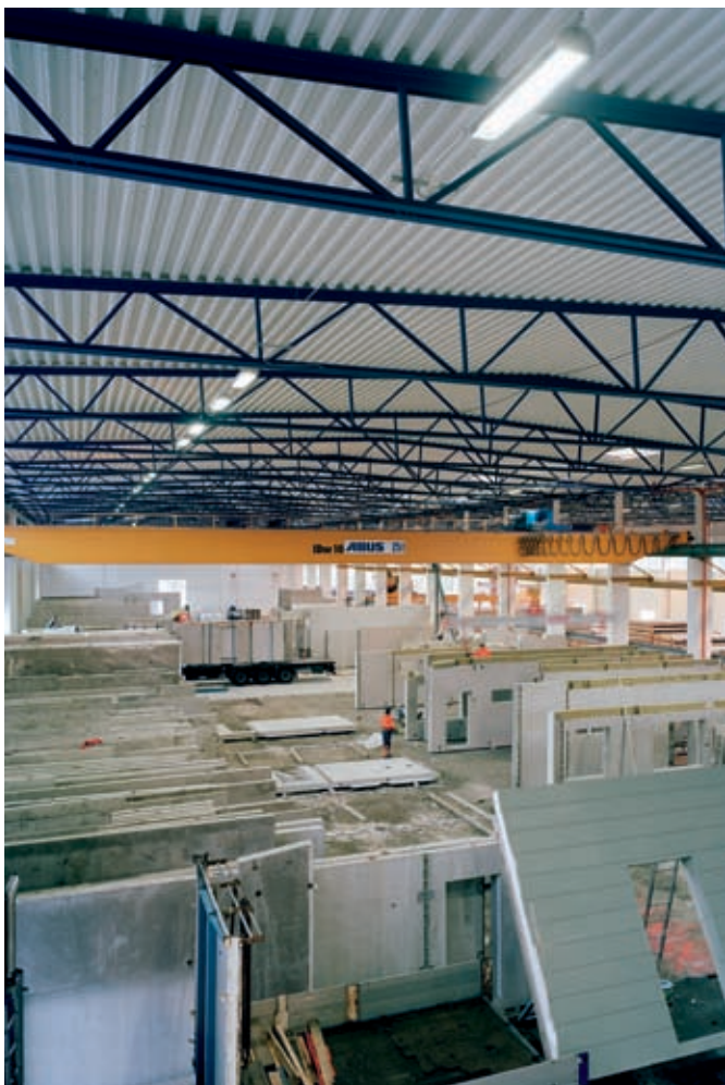
Завод по производству бетона, Бетонфабрик, Уприсенхамн
