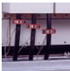
Датчики тока разъемного типа
